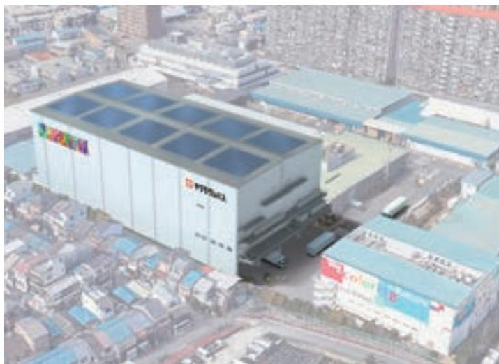
100年を超える業歴を有する大手文具メーカーである株式会社サクラクレパスが、国内の主力工場である大阪工場の敷地内に、関連会社も含めた物流業務を集約するために計画された施設です。建物の屋上に太陽光発電設備を設置することで環境への対策を行うとともに、外壁の色彩・サイン計画については近隣の方々に配慮した建物となっています。また、浸水対策としてキュービクルを底上に設置し、非常時の影響を軽減するようにしています。
